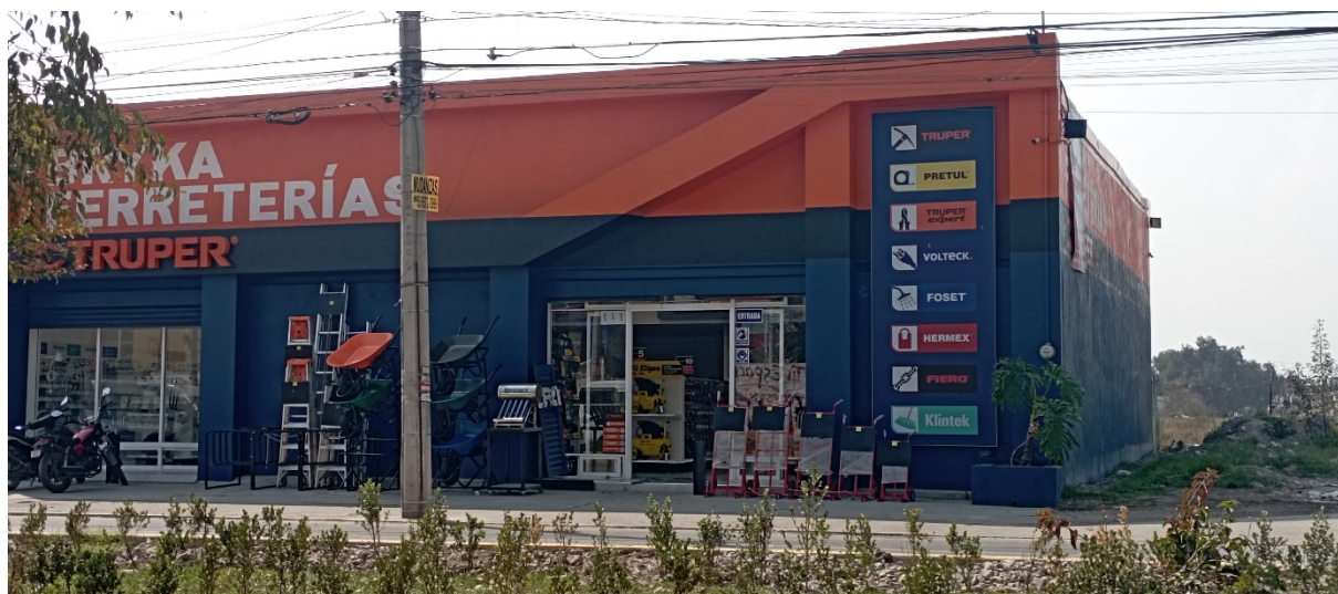
Imagen 9. Estructura que representa a la imagen 7 y 8 antes de ser concluida para dar servicio a la comunidad, un ejemplo más de desalojo y ocupamiento estructural de los espacios urbanos
