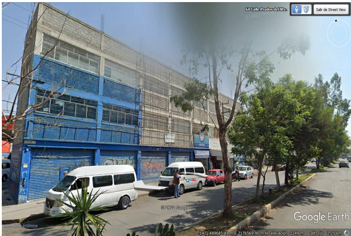
Imagen 2. Edificio abandonado hace un par de años por cuestiones económicas y de violencia en la zona, foto tomada de google earth
